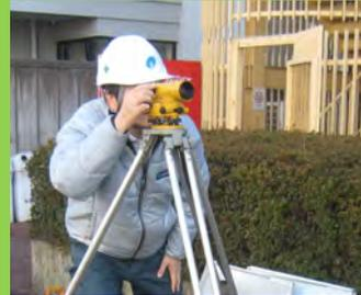
測量器具を使用し、配管の勾配を確認します「勾配確保、ヨシ!!」
